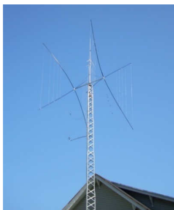
Figura 21 - Antena "Cubica de Quadro" com dois elementos. Porém pode-se verificar que em cada suporte em X, há cinco antenas (fios), portanto tratam-se de cinco cúbicas dividindo o mesmo sistema de sustentação.
