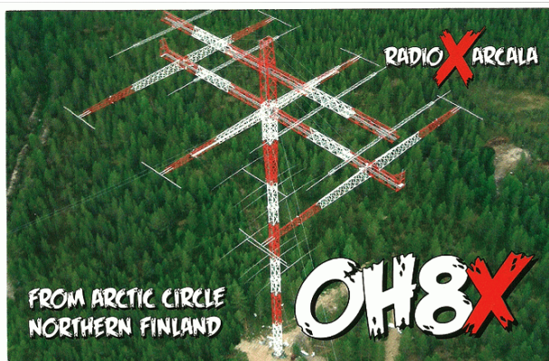
Figura 22 - Essa é a famosa Yagi de 3 elementos para 80m da Radio Arcala!! Trata-se de um grupo de radioamadores finlandeses que construíram esse arranjo: 3 el 80m + 4 el 40m + 2x 4 el. 20m. A torre inteira é giratória e o motor na base é gigantesco. A torre tem 80m de altura total.
