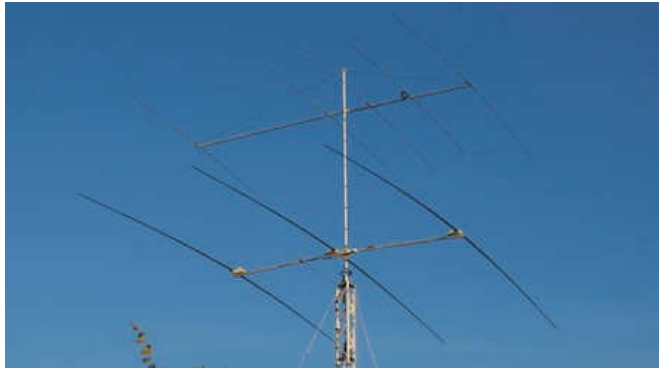
Figura 17 - Yagi de 3 elementos para 15m (monobanda) e yagi de 5 elementos (OPDES) para 6m mais acima no mastro. Note que o mastro gira e aponta as duas na mesma direção.
